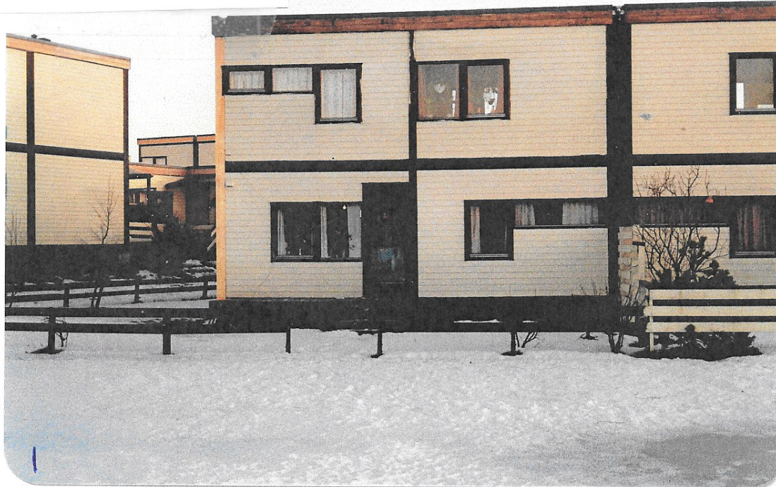
Bilde 1 tatt fra gressplen bakside av rekkehuset. Dere ser hagegjerde laget av 2 bord og spikerfeste fra fundament i bakken.
